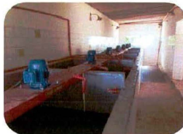
Situação de antes e depois da troca dos agitadores dos tanques da ETA I de Colatina/ES
