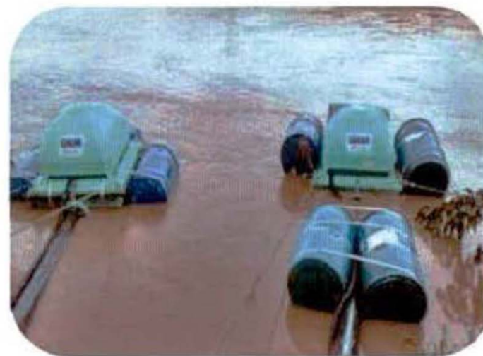
Substituição da balsa de captação (à esquerda) por dois flutuadores (à direita) no sistema de captação da ETA modular de Cachoeira Escura, Belo Oriente/MG
