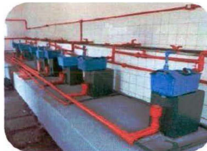
Instalação de caixas dosadoras de produtos químicos na ETA I de Colatina/ES
