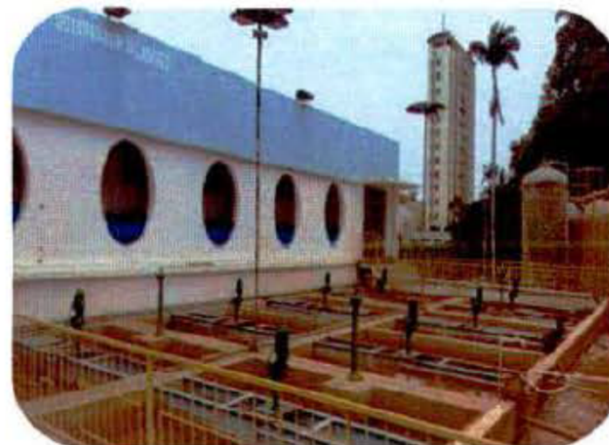
Imagens dos agitadores instalados na ETA Central – Governador Valadares/MG
