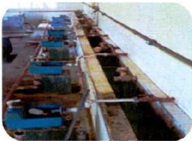
Instalação de caixas dosadoras de produtos químicos na ETA I de Colatina/ES
